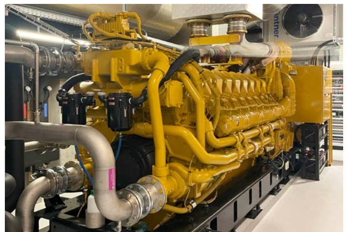
Notstromaggregate Seewasserwerk Frasnacht
